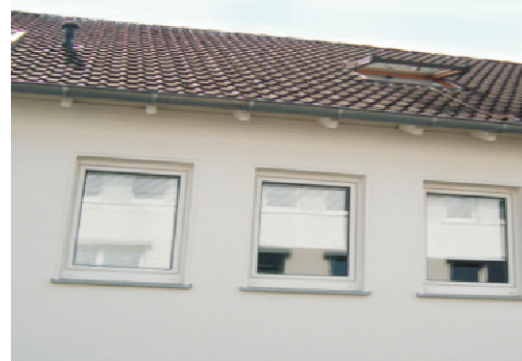
Wärmeschutz u. Sichtschutz durch Verspiegelung
